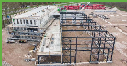
Nieuwbouw Bredenoord Apeldoorn
